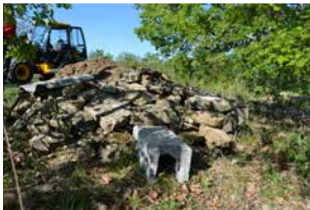
COUX, Garenne en construction, en moellons, pierres, tôles fibrociment et terre. Garenne terminée à St Marcel d'Ardèche. (Dimensions de 3 m x 3 m et 1 m de hauteur).
