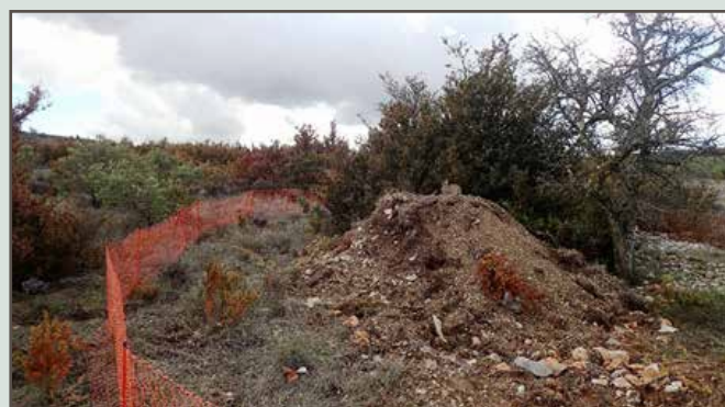
COUX, Garenne en construction, en moellons, pierres, tôles fibrociment et terre. Garenne terminée à St Marcel d'Ardèche. (Dimensions de 3 m x 3 m et 1 m de hauteur).
