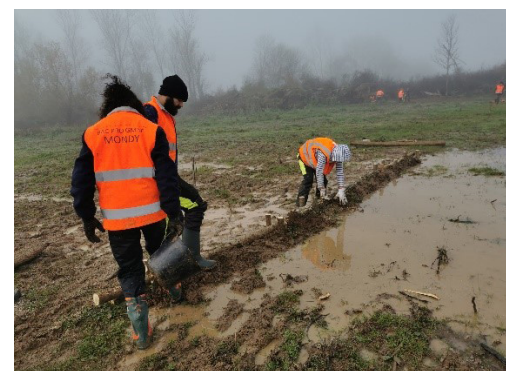
Création d'un seuil pour une meilleure répartition de l'eau.
